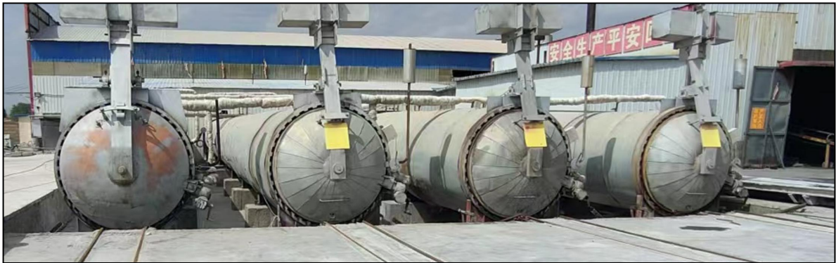
实际建设 4 条蒸压釜生产线
