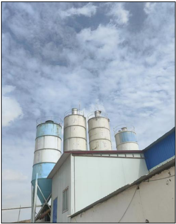
原料筒仓及仓顶除尘器
