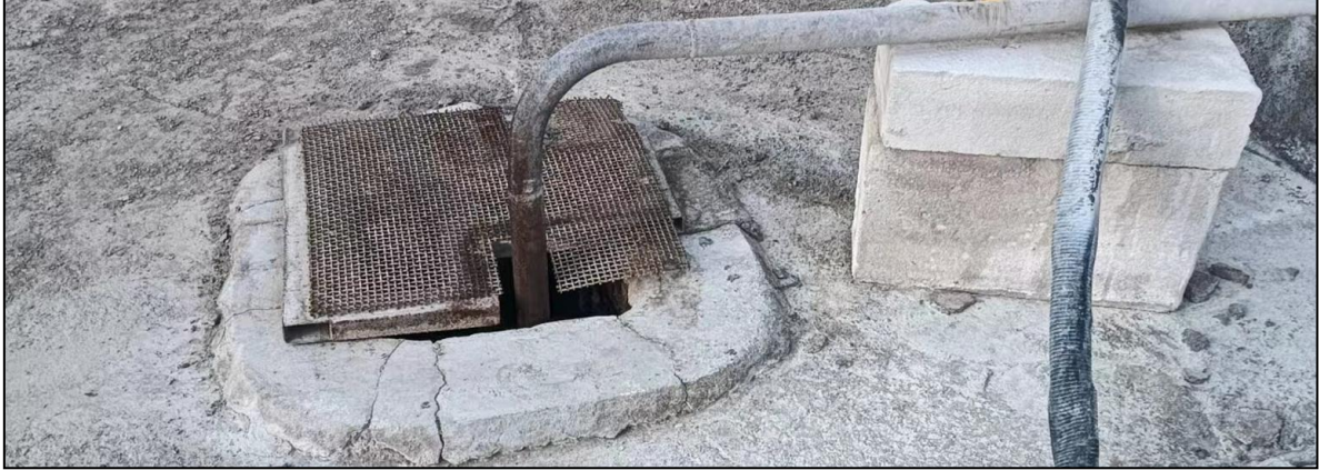
生产废水沉淀池
